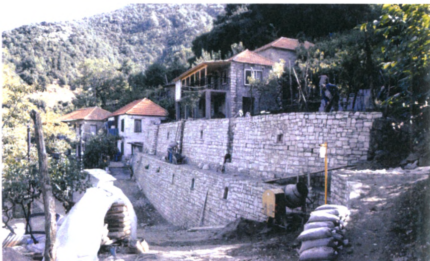
Κατασκευή πάνω και κάτω τοιχοποιίας για την διαμόρφωση του χώρου πάνω από την πλατεία (έργο του Συλλόγου), 1988-89.
